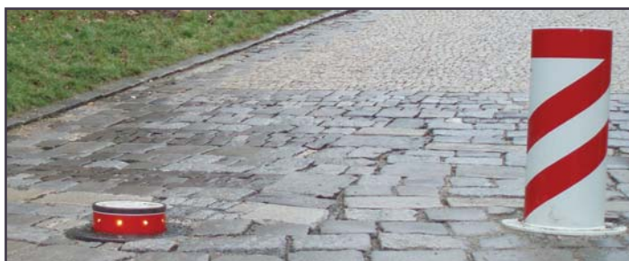
Výsuvný sloup ve fázi „předvysuvu“, LED diody blikají (sloup se vysune asi 10 cm, zastaví se a poté se znovu rozjede)
