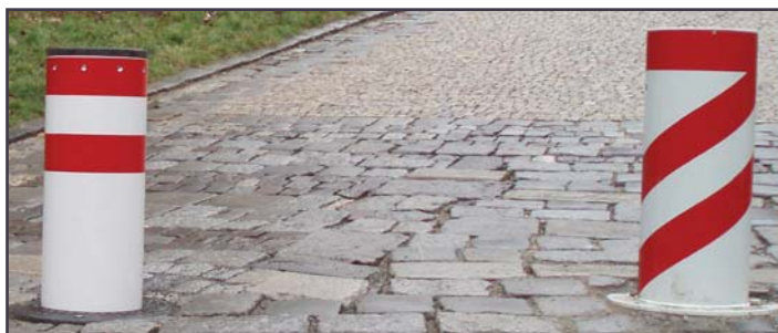
Výsuvný sloup je plně vysunut, tvoří nepřekonatelnou bariéru
